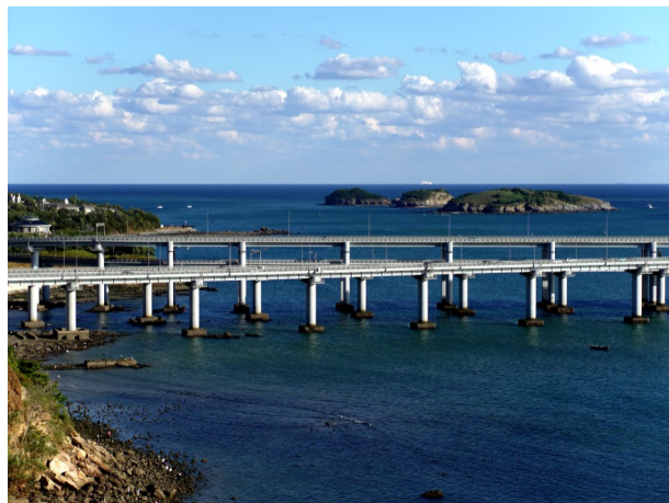
星海湾跨海大桥
